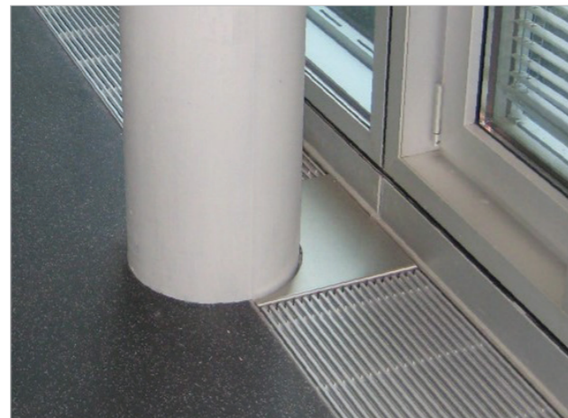
EINBAU MIT BLINDBLECH UND SÄULENAUSSCHNITT
