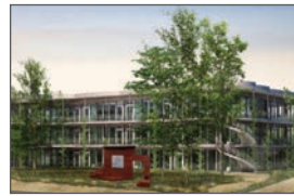
Schulanlage Wallrüti - Zürich
