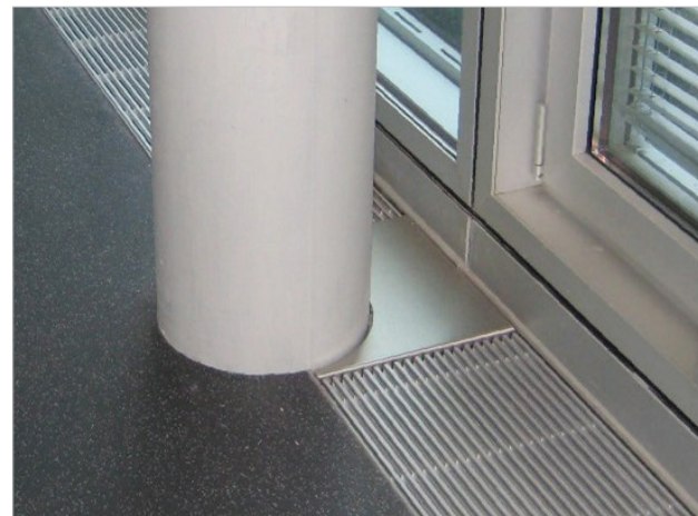
EINBAU MIT BLINDBLECH UND SÄULENAUSSCHNITT
