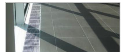
Durch die Kaltverpressung der Aluminiumteile entsteht eine gewünschte Bombierung. Diese Wölbung ist normal und erhöht im weiteren die Belastbarkeit der Gitter.
