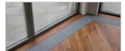
Durch die Kaltverpressung der Aluminiumteile entsteht eine gewünschte Bombierung. Diese Wölbung ist normal und erhöht im weiteren die Belastbarkeit der Gitter.
