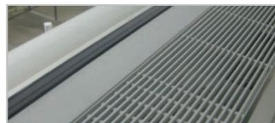
Durch die Kaltverpressung der Aluminiumteile entsteht eine gewünschte Bombierung. Diese Wölbung ist normal und erhöht im weiteren die Belastbarkeit der Gitter.
