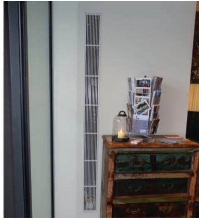
**SICHERHEITS - GITTER FÜR ENTLÜFTUNGSSYSTEM**
