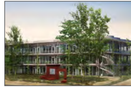
Complexe scolaire Wallrüti - Zurich
