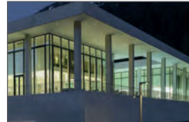
Piscine couverte Ovaverva - St. Moritz
