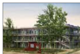
Complexe scolaire Waltrüti - Zurich
