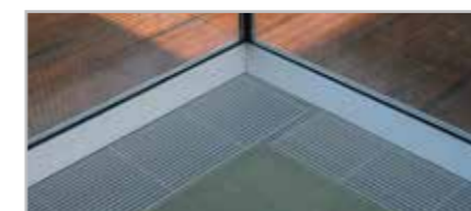
Un léger cintrage sur la largeur de la grille résulte du pressage à froid des pièces en aluminium.
