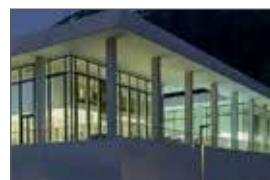
Piscine couverte Ovaverva - St. Moritz
