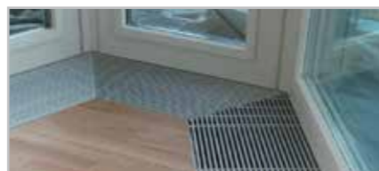
Un léger cintrage sur la largeur de la grille résulte du pressage à froid des pièces en aluminium.
