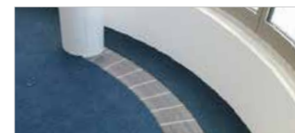
Un léger cintrage sur la largeur de la grille résulte du pressage à froid des pièces en aluminium.
