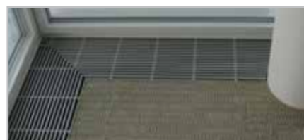
Un léger cintrage sur la largeur de la grille résulte du pressage à froid des pièces en aluminium.
