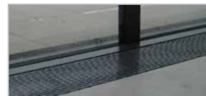
Un léger cintrage sur la largeur de la grille résulte du pressage à froid des pièces en aluminium.
