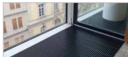
Un léger cintrage sur la largeur de la grille résulte du pressage à froid des pièces en aluminium.
