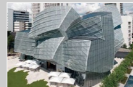
Plant Gehry - Bâle
