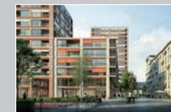
Areal „Lokstadt“ Winterthur
