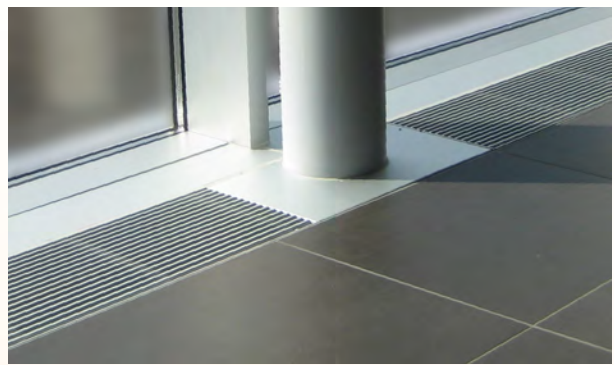
Grille avec tôle de finition enserrant un pilier
